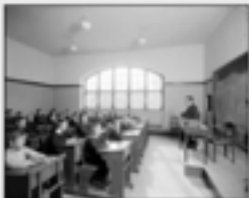
Interiör i klassrummet i Uppsala universitet, Karlavagnen (Bildkälla: uppsalafoto.se)
